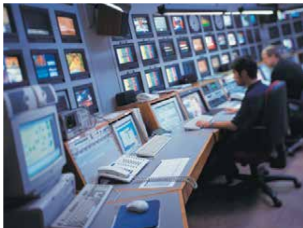
RDU-Cooling 监控界面
